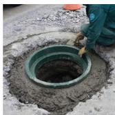
*\*En zonas donde aparezca el hierro de la armadura, limpiar y aplicar mortero anticorrosión Pavifer, dejar secar al menos 1 hora.*
