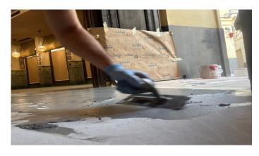
Una vez la superficie completamente seca >10 días y con humedad <4%, aplicar el **Hidrofugante Paviguard.**
