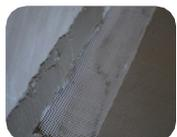
En los laterales solapar según el soporte estructural.
