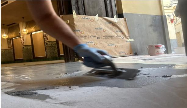
Una vez la superficie completamente seca >10 días y con humedad <4%, aplicar el **Hidrofugante Paviguard**.
