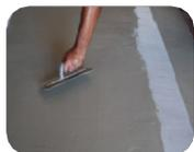
Aplicar con llana en 3 pasadas a mínimo espesor. Si es necesario, colocar la malla adecuada en medio del revestimiento.
