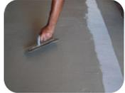
Aplicar con llana en 3 pasadas a mínimo espesor. Si es necesario, colocar la malla adecuada en medio del revestimiento.
