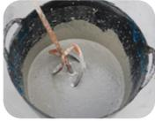
Vertido del **componente B** líquido y añadir lentamente el polvo (saco 25 kg) hasta conseguir una masa homogénea y exenta de grumos.
