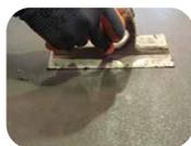
La aplicación se puede realizar con llana de acero, caucho.
