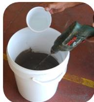
Mezclar los componentes **A + B** con un batidor a bajas revoluciones hasta obtener una perfecta homogeneización.
