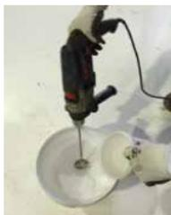
Mezclar los 2 componentes de forma homogénea. La baja viscosidad del **Poliuretano alifático**, permite ser aplicado en estado puro.
