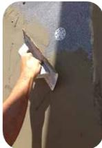
Pasadas 24 horas aprox. se regulará la superficie y a continuación con la pasta fresca se extenderá la malla a lo largo y ancho de toda la superficie. Una vez la superficie seca, se aplicará una pasada de mortero a fin de regularizar y tapar la malla vista o alguna pequeña irregularidad.
