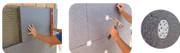
Una vez colocadas las placas con las juntas intercaladas y con el mortero seco (24 horas), se perforarán para la colocación del taco de sujeción.
