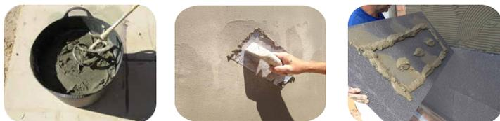
Extender el mortero con llana dentada (2-3 m<sup>2</sup>), encolar y colocar de la placa.
