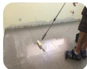
\* Entre capas, deben transcurrir al menos un mínimo de 6 horas y un máximo de 24 horas. En caso de rebasarse este máximo se procederá a un lijado superficial previo.
