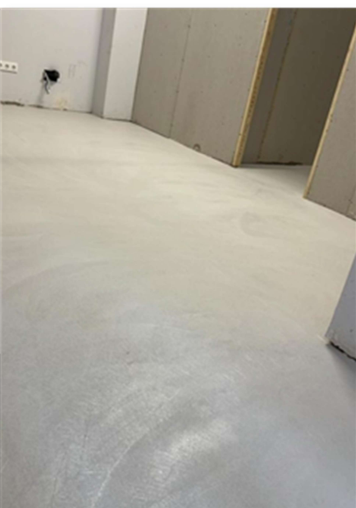
Continuidad: Siendo un importante factor en lugares con paredes o estructuras.
