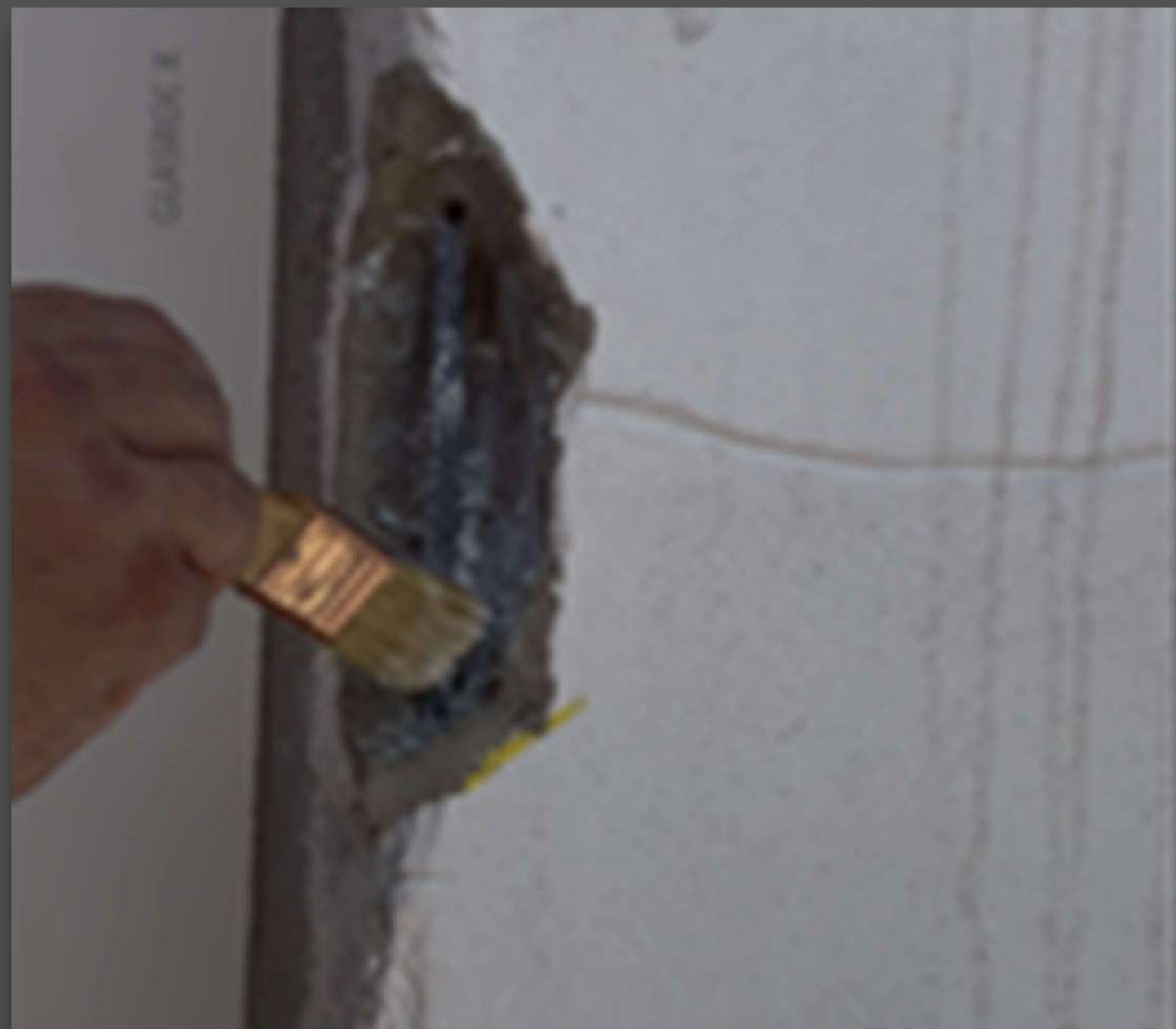
4. Se puede aplicar sobre el hormigón como puente de unión.
