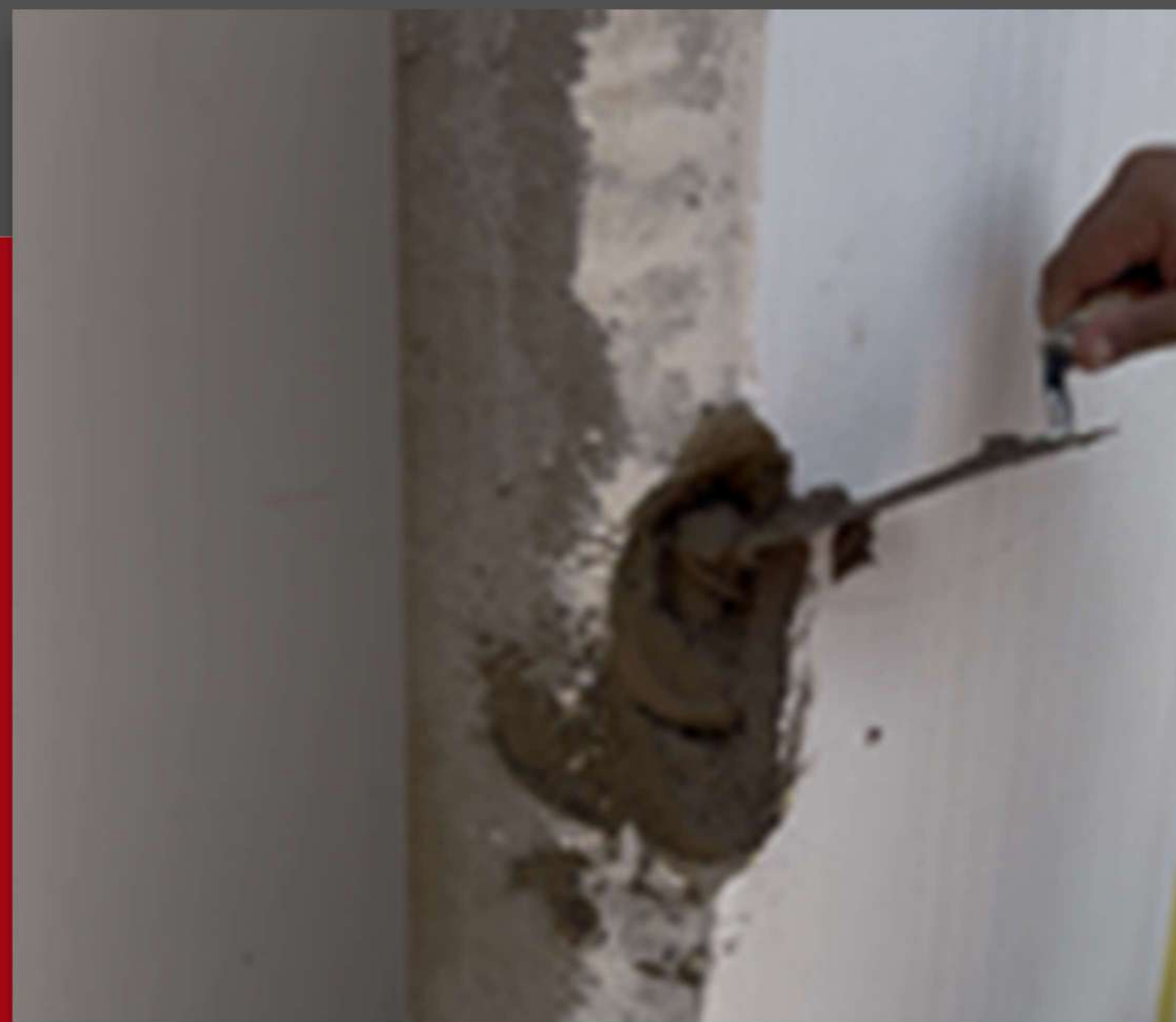
6. Aplicar el hormigón o mortero de recubrimiento.
