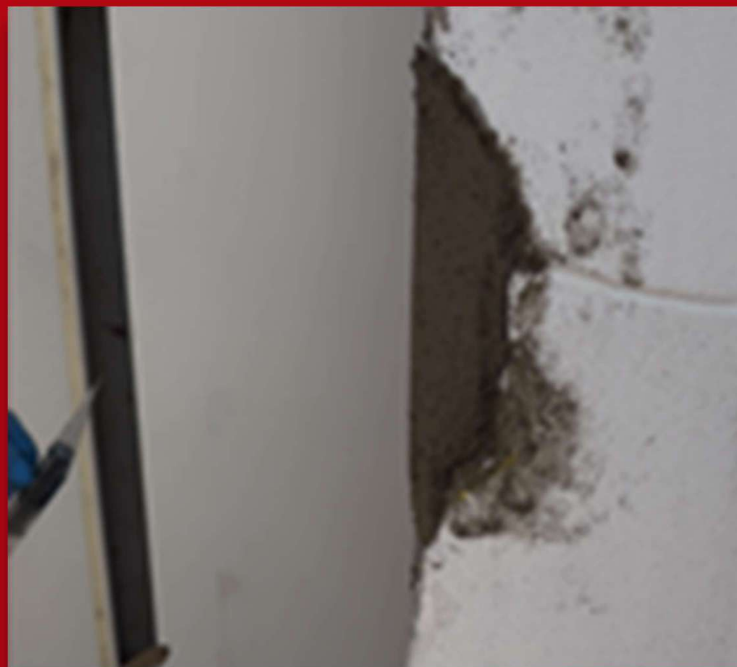
8. Acabado para ser revestido.
