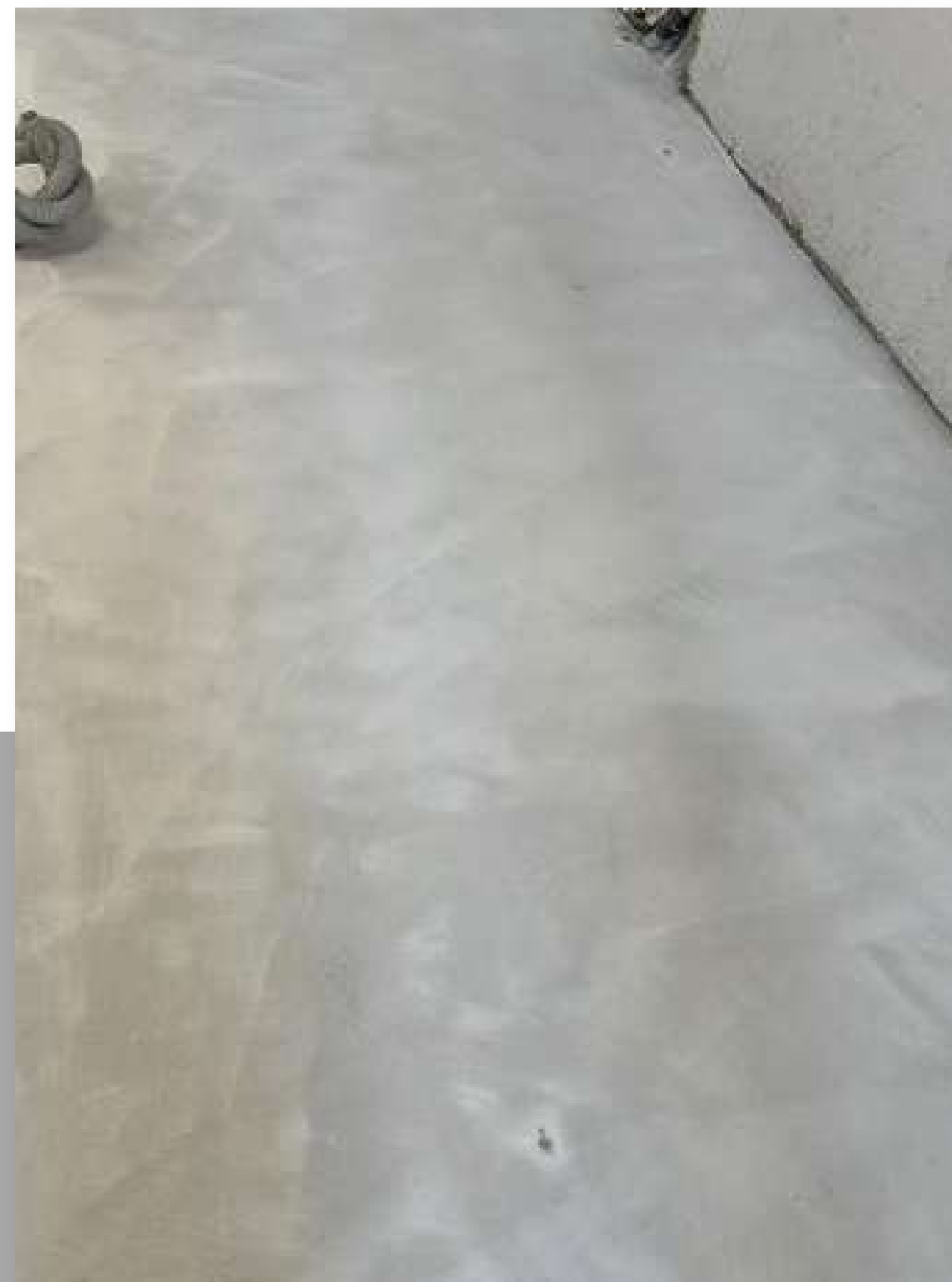
Lijado: Cualquier imperfección, puede provocar un mal resultado, teniendo en cuenta este factor.
