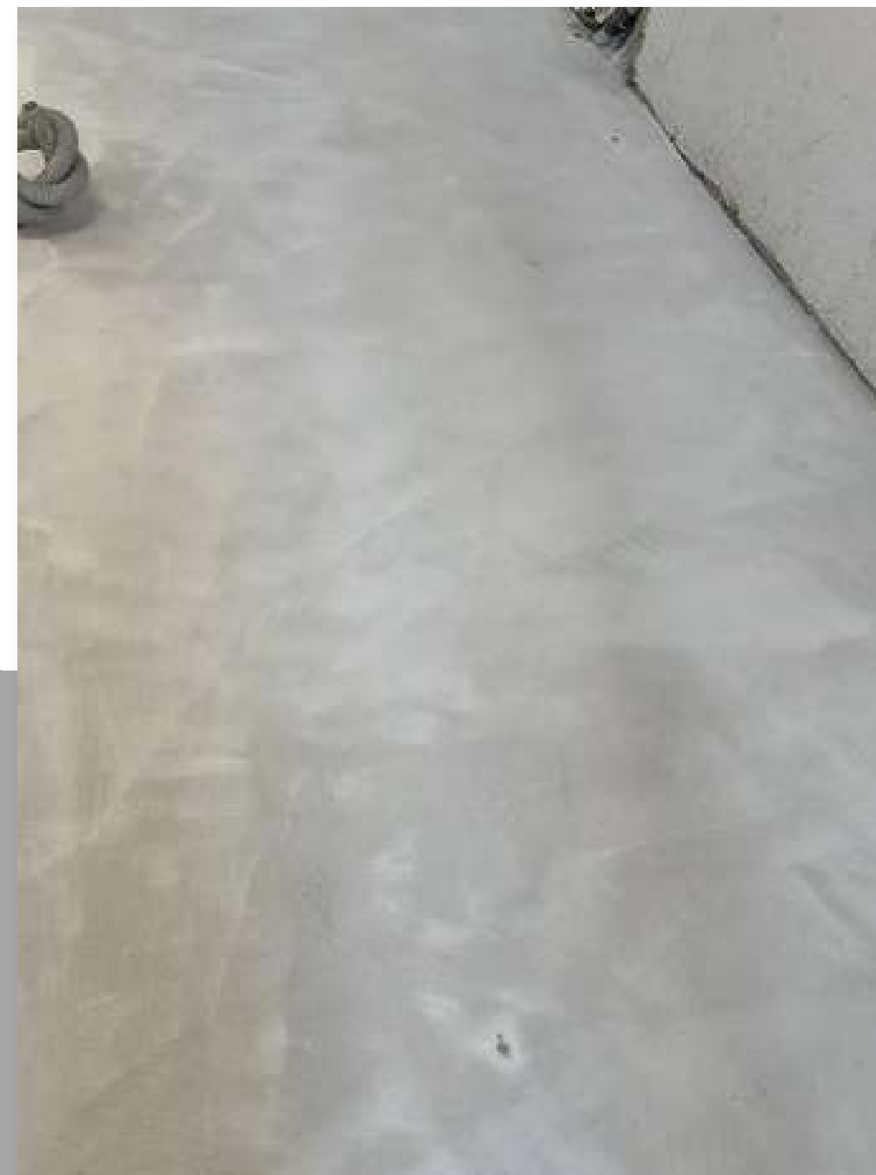
Lijado: Cualquier imperfección, puede provocar un mal resultado, teniendo en cuenta este factor.
