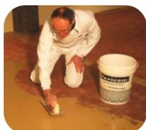
Aplicar manualmente con la herramienta adecuada en capas de máximo 0,5 mm hasta conseguir el efecto deseado.
