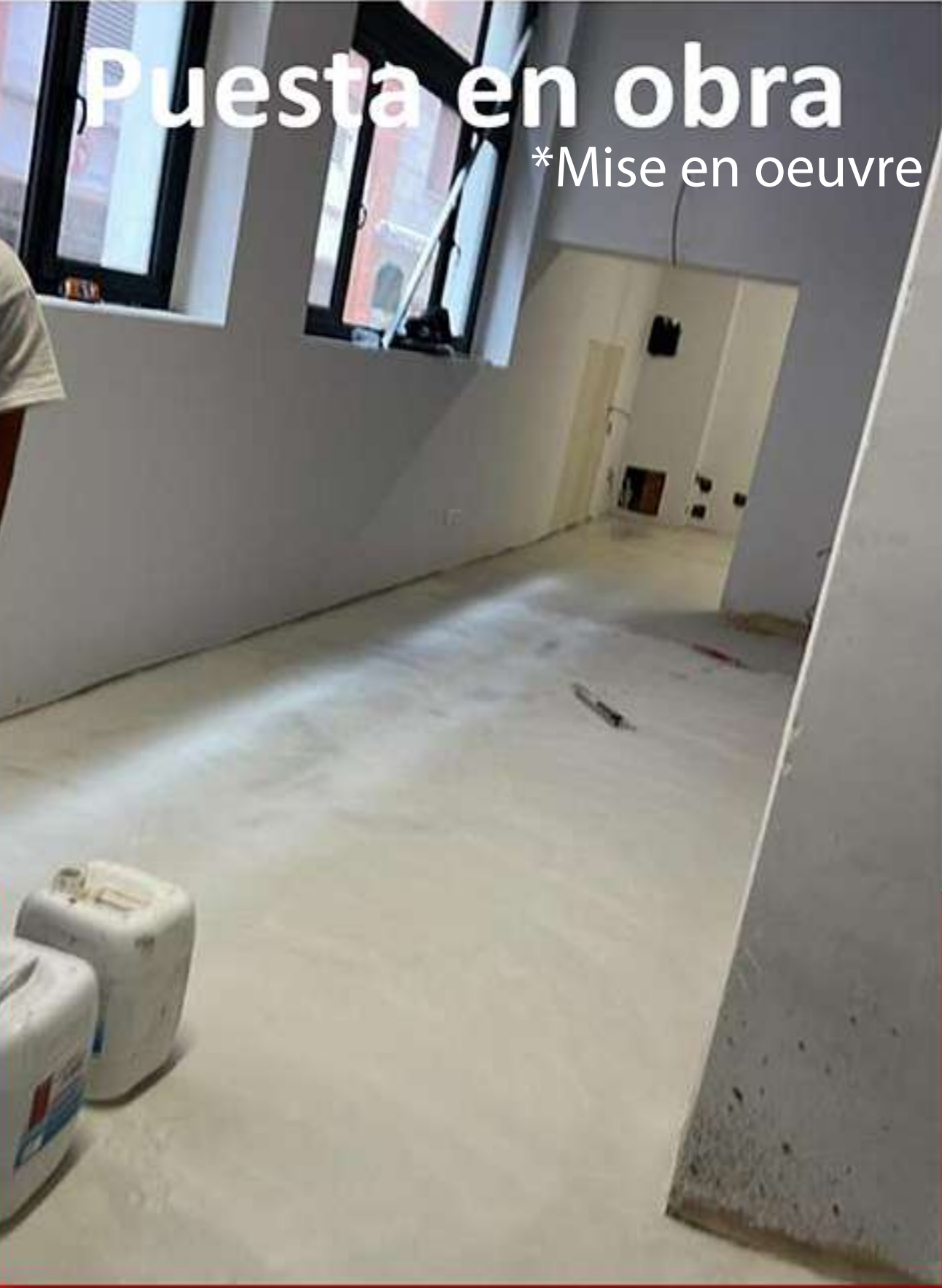
Détail actuel : Différentes zones de passage, joints à prendre en compte et déversements de produit.
